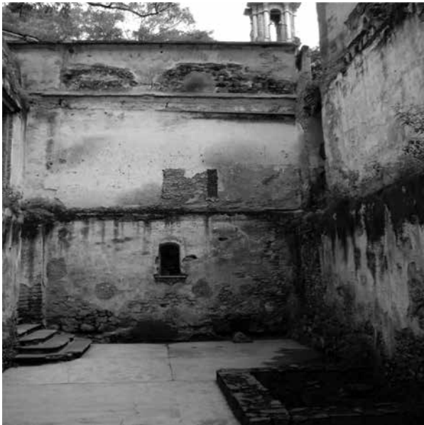
Figura 4. Edificio del molino de Tuzcacuaco. Fotografía de Rosana Espinosa Olivares, 2011.
