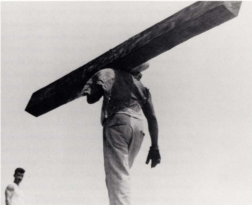
Trabajador cargando una viga , ca. 1928. Núm. de inv. 35309
