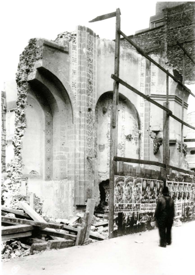
Luis Limón, Demolición de la iglesia de Santa Brígida , 1934, Ciudad de México, FCNMH / 91-61
