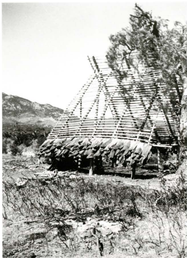
Raúl Estrada Discua (atribuida), Estructura de una casa de pencas de maguey en construcción en el Valle del Mezquital, ca. 1945 , Hidalgo, FCNMH / 485-38
