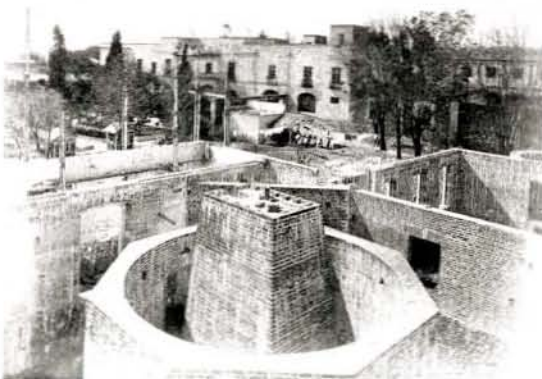
Autor no identificado, Base y torreón para instalar el telescopio Gran Ecuatorial, ca. 1886. Col. Instituto de Astronomía, UNAM
