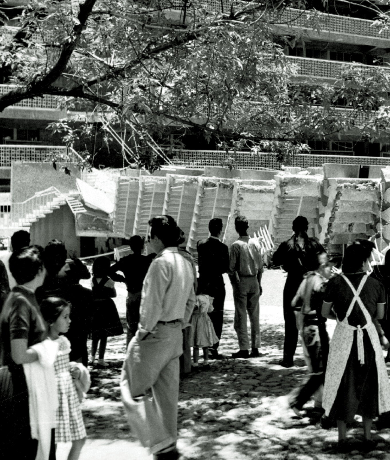
© 751178 Agencia Casasola . Gente observa los edificios destruidos por el temblor , México D.F., 1937, colección Revista Hoy , Secretaría de Cultura. INAH.SINAFO.FN.MX.
