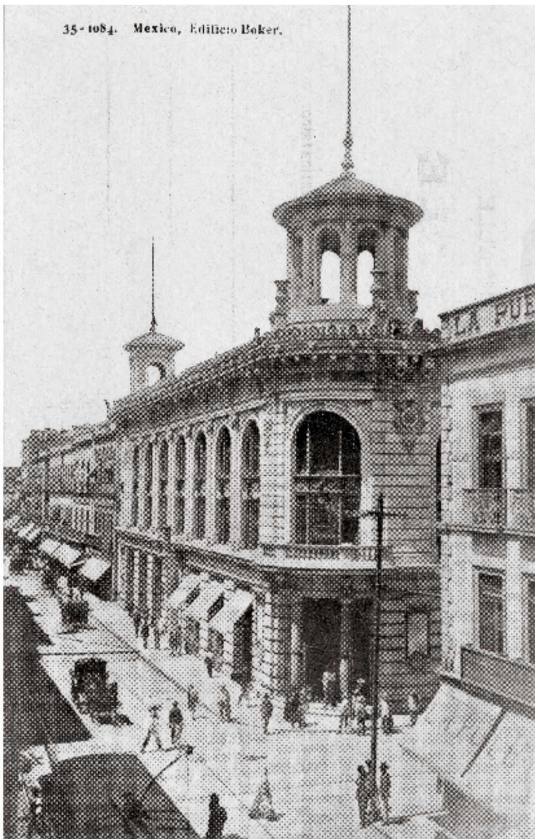
© 608789 "Edificio Baker", México, ca. 1905, Serie Benita Cervantes, Colección Incremento Acervo, Secretaría de Cultura. INAH.SINAFO.FN.MX.
