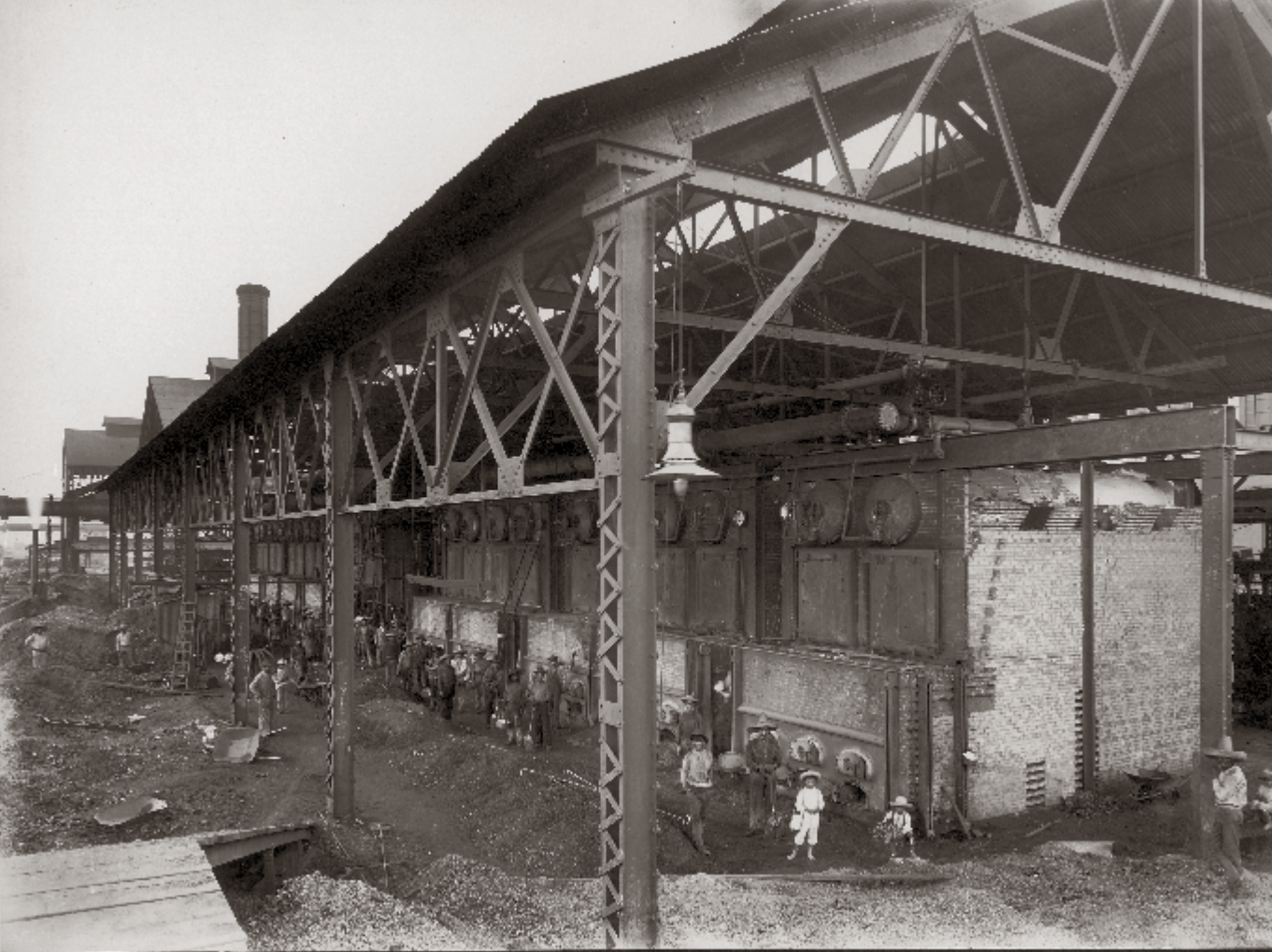
Cia Fundidora de Hierro y Acero de Monterrey, S.A. — N°31. Instalación de calderas.
