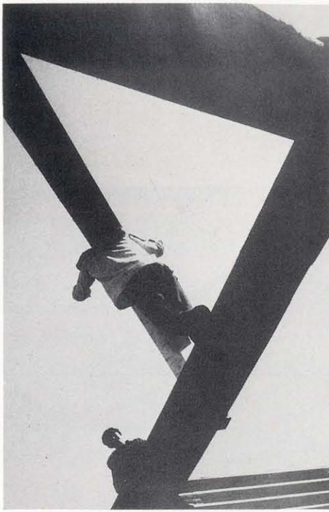
Boris Ignatovich, En el edificio , Moscú, 1929
