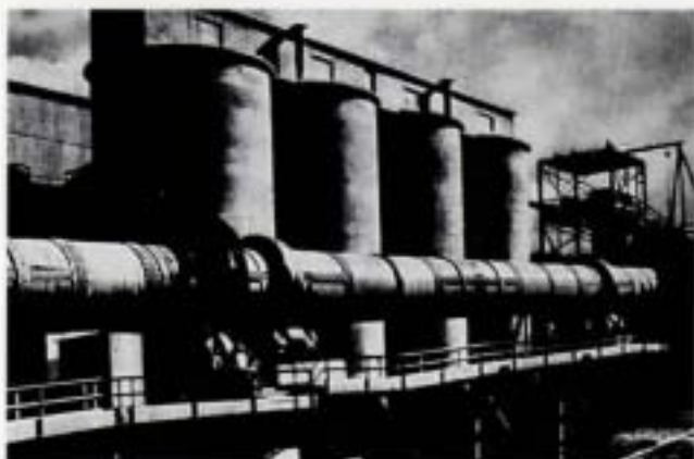
Aurora Eugenia Latapi, Fábrica de cemento La Tolteca . 1931
