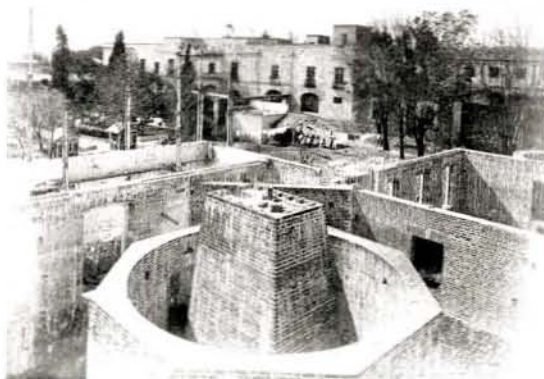
Autor no identificado, Base y torreón para instalar el telescopio Gran Ecuatorial, ca. 1886. Col. Instituto de Astronomía, UNAM
