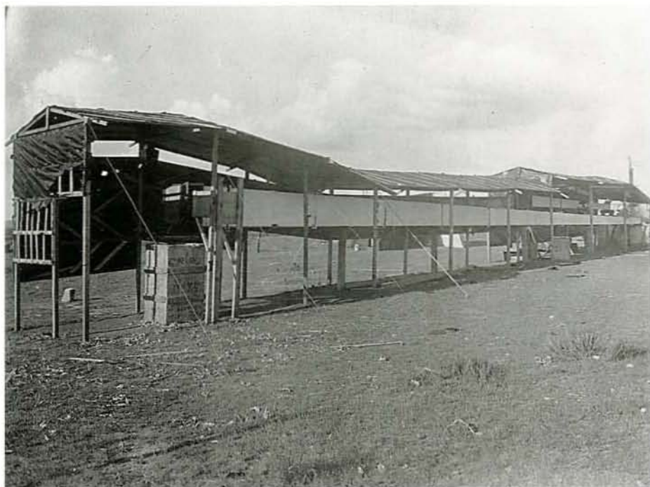
Autor no identificado, Cámara fotográfica de gran distancia focal , construida para los astrónomos mexicanos para fotografiar el eclipse solar en 1923. Col. Instituto de Astronomía, UNAM
