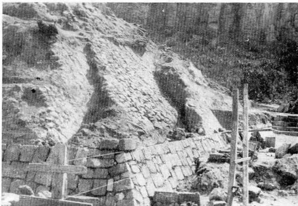
Lám. III.—Reconstruyendo el talud, ángulo sureste. Pueden verse los tres taludes anteriores.
