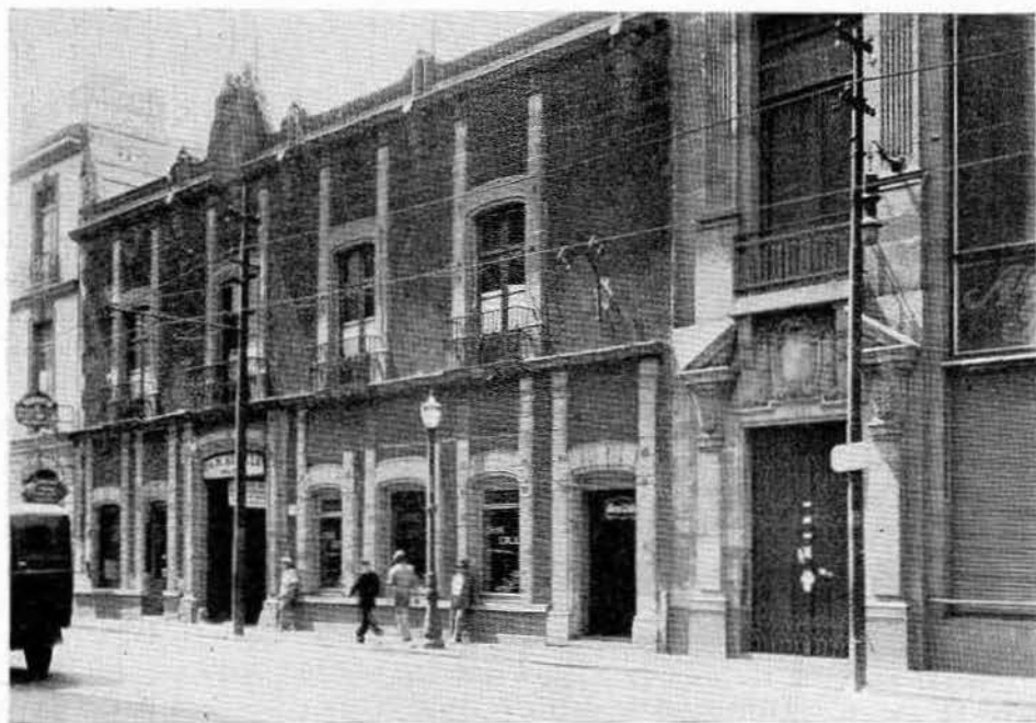
Lám. V.—Casa No. 33 de la Avenida Venustiano Carranza de la Ciudad de México, declarada monumento nacional en 1960, y cuya fachada fue trasladada al Jardín Pacheco de la misma Ciudad.
