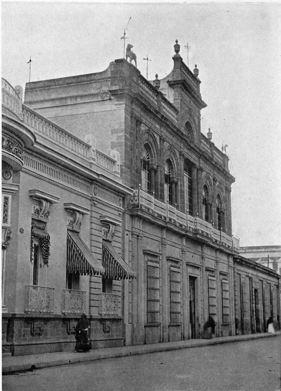
EL EDIFICIO QUE APARECE EN EL CENTRO, SITUADO EN LA AVENIDA ALCALDE, FRENTE AL JARDÍN NÚÑEZ (ANTIGUA PLAZA DE STO. DOMINGO) DE LA CIUDAD DE GUADALAJARA, ES EL LUGAR DONDE ESTUVO ESTABLECIDA LA PRIMERA IMPRENTA. SU ESTADO EN SEPTIEMBRE DE 1911.
