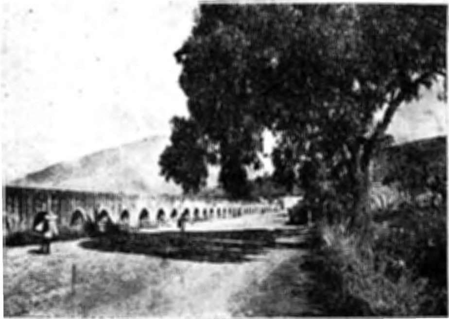
Acueducto de la Villa de Guadalupe.
