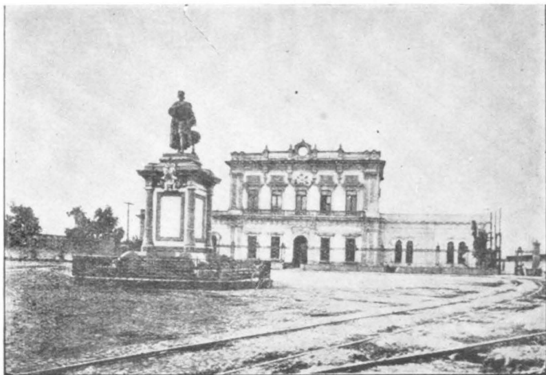
Fachada de la Estación del Ferrocarril Mexicano, en la Plaza de Buenavista. Ciudad de México, D. F.
