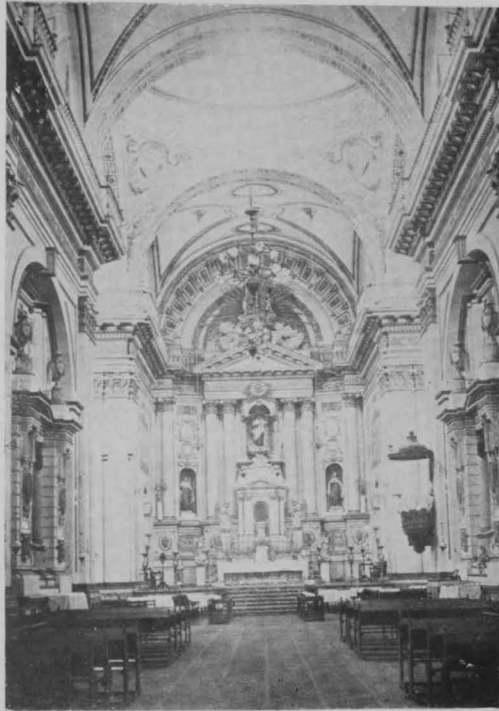
CELAYA.—Interior de la Iglesia del Carmen. (Fot. de la Inspección.)
