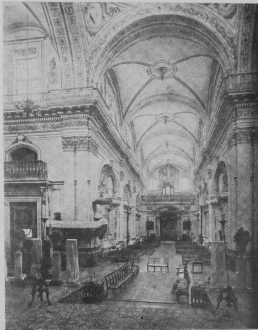
CELAYA.—Interior de la Iglesia del Carmen (Desde el presbiterio.)
