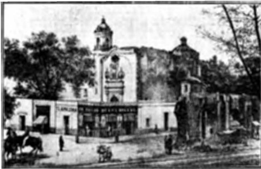
El convento de San Cosme en 1880. (Litografía publicada en la obra "México Pintoresco, Artístico y Monumental," con la siguiente leyenda: "Ex-convento de los descalzos viejos.—Hasta aquí llega el acueducto de la Verónica que une el agua delgada del Desierto, los Leones y Santa Fe."
