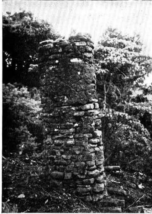
Foto 12. Columna del edificio B.
