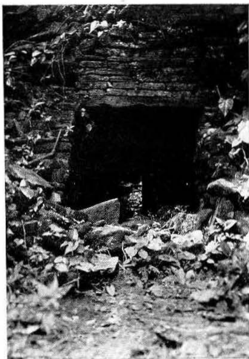
Foto 6. Monumento A. Entrada al pasaje subterráneo.
