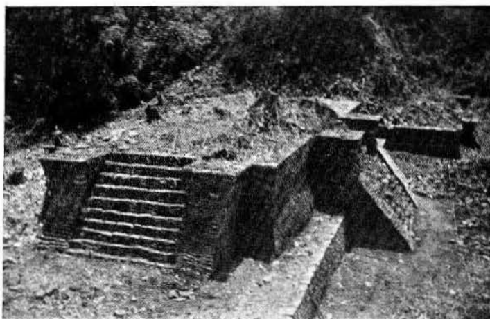
Foto 17. Lados poniente y sur del edificio B. Al fondo, el monumento B.
