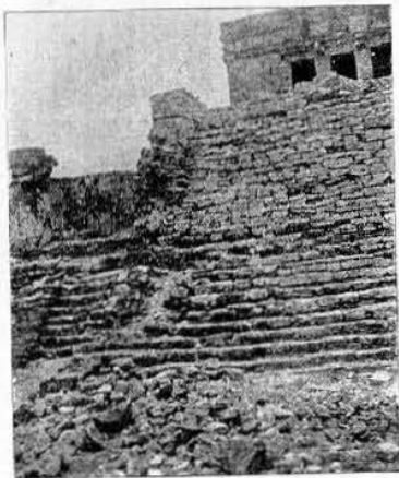
Fig. 23.—Estado de la escalinata (antes de los trabajos).
