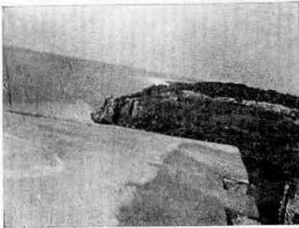
Fig. 13.—El techo después de reconstruído.
