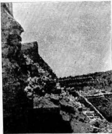
Fig. 21.—Alfardas de la escalera (antes de los trabajos).
