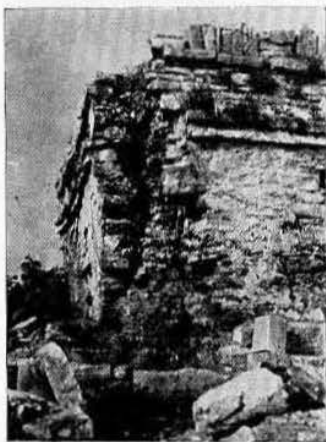
Fig. 52.—Edificio número 9, lado sur (después de los trabajos).
