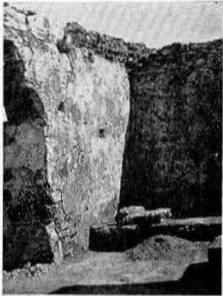
Fig. 57.—Angulo N. O. de la subestructura.
