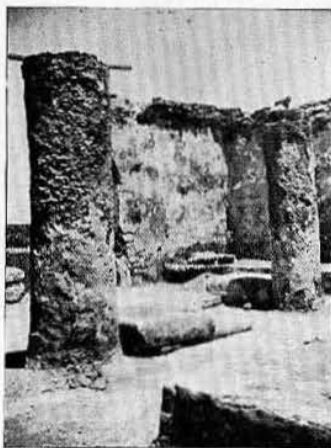
Fig. 35.—Columnas monolíticas galería norte; en el suelo se ven los capiteles.
