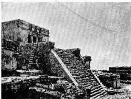
Fig. 9.—El Castillo, al fondo el edificio número 9 (después de los trabajos).
