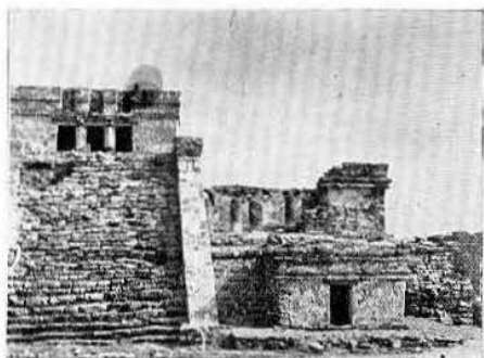
Fig. 25.—La misma galería (después de los trabajos).
