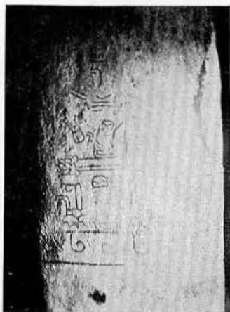
Fig. 17.—Pinturas de la primera capa de estuco de la columna norte.
