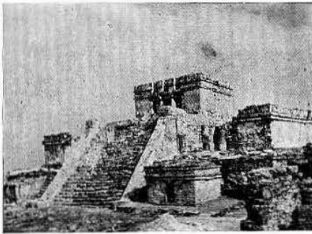
Fig. 7.—El Castillo (después de los trabajos).
