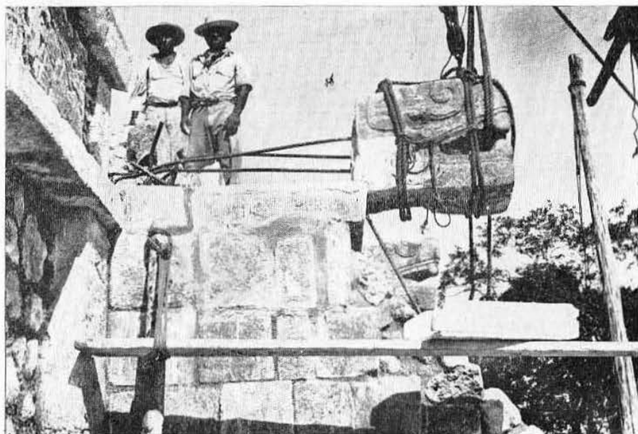
Lám. VII. Véase la forma en que se colocaron las varillas a las cabezas de serpientes que carecían de "espiga".
