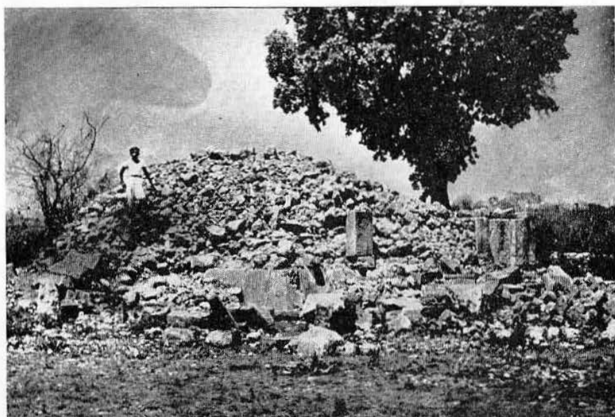
Lám. II. Templo de las Aguilas. El lado oeste antes de los trabajos de restauración.
