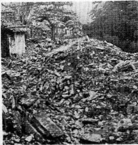
Lám. II. El Patio Sureste visto desde el lado sur, antes de iniciar las obras.
