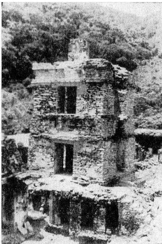
Lám. XII.—La torre de El Palacio al terminar los trabajos de 1949.
