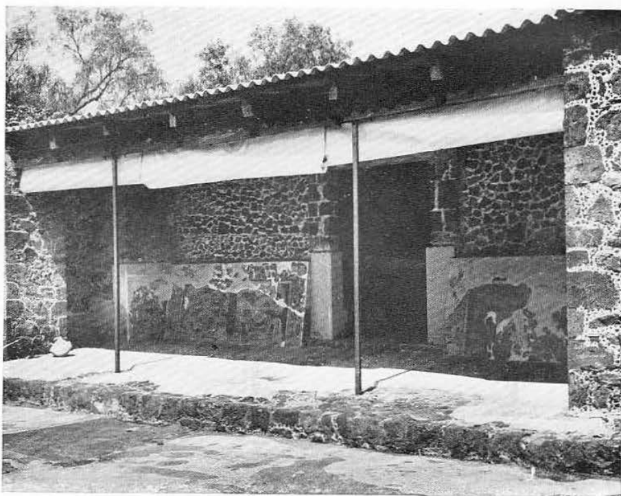
Lám. X. El mismo pórtico con las cortinas enrolladas para hacer visibles las pinturas.
