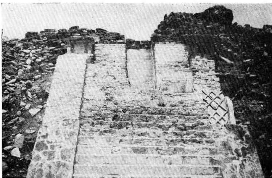
Lám. XX. Otro aspecto de la misma escalinata del Edificio B.
