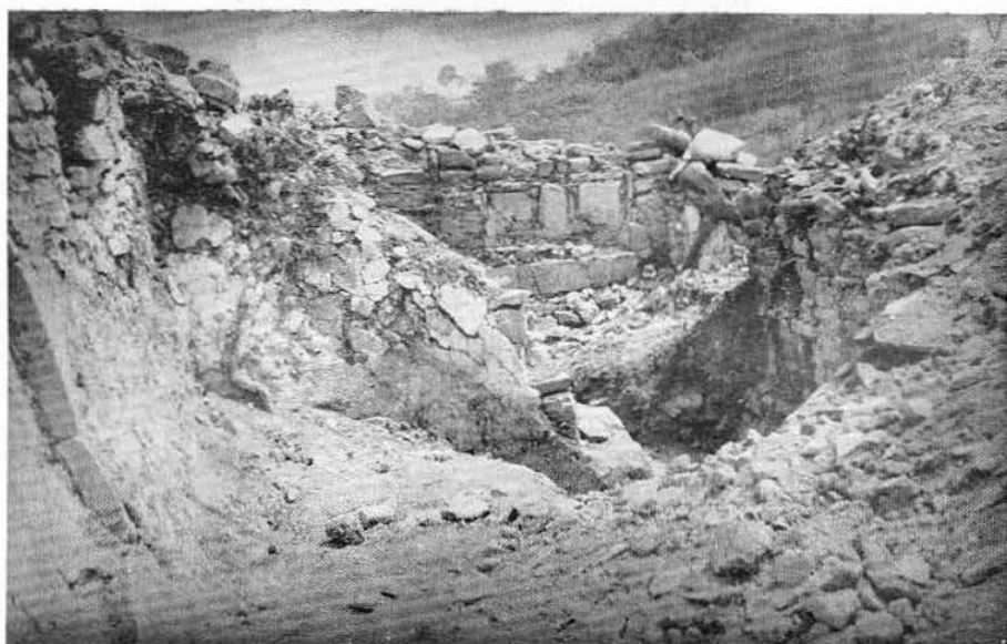
Lám. XV. Aspecto del lado poniente del Edificio A, al emprenderse su reparación.
