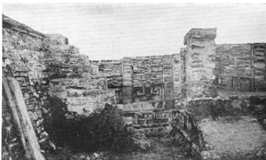
Lám. XVI. Aspecto del lado poniente del Edificio A, al concluirse su reparación.
