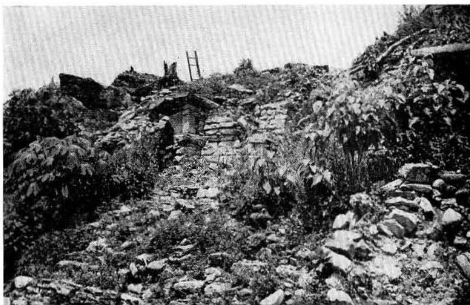
Lám. VIII. Patio de Pelota Norte, después de haberse repuesto los materiales en su sitio.
