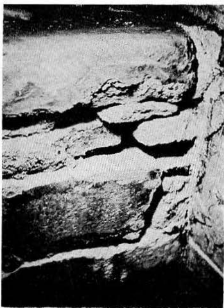
Lám. XXVIII.—Contrafuerte y extremo de la losa horizontal adosados al sepulcro en el lado Sur.
