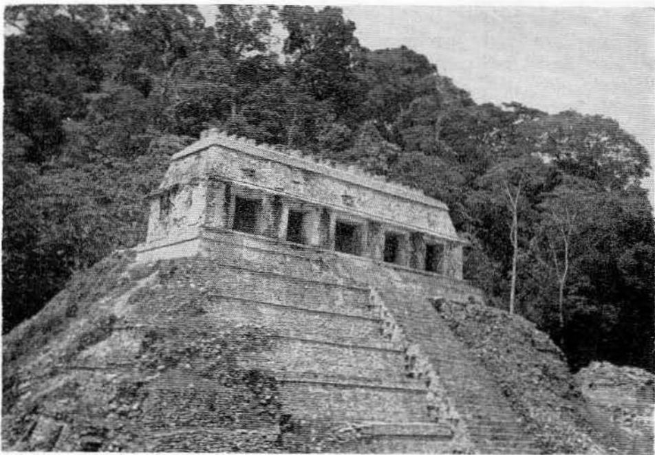
Lám. XXI.—El Templo de las Inscripciones al terminarse las obras de restauración.
