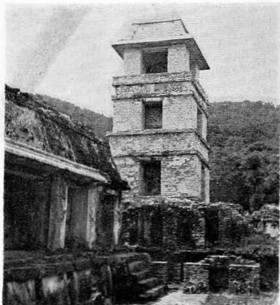
Lám. VIII.—La torre del Palacio totalmente restaurada.
