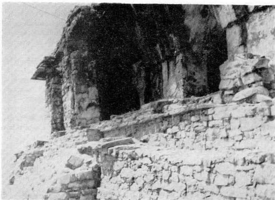
Lám. XXXVII.—Basamento y pórtico del Templo de la Cruz, después de retirado el escombro y consolidar los elementos arquitectónicos que se descubrieron en el curso de esta temporada.
