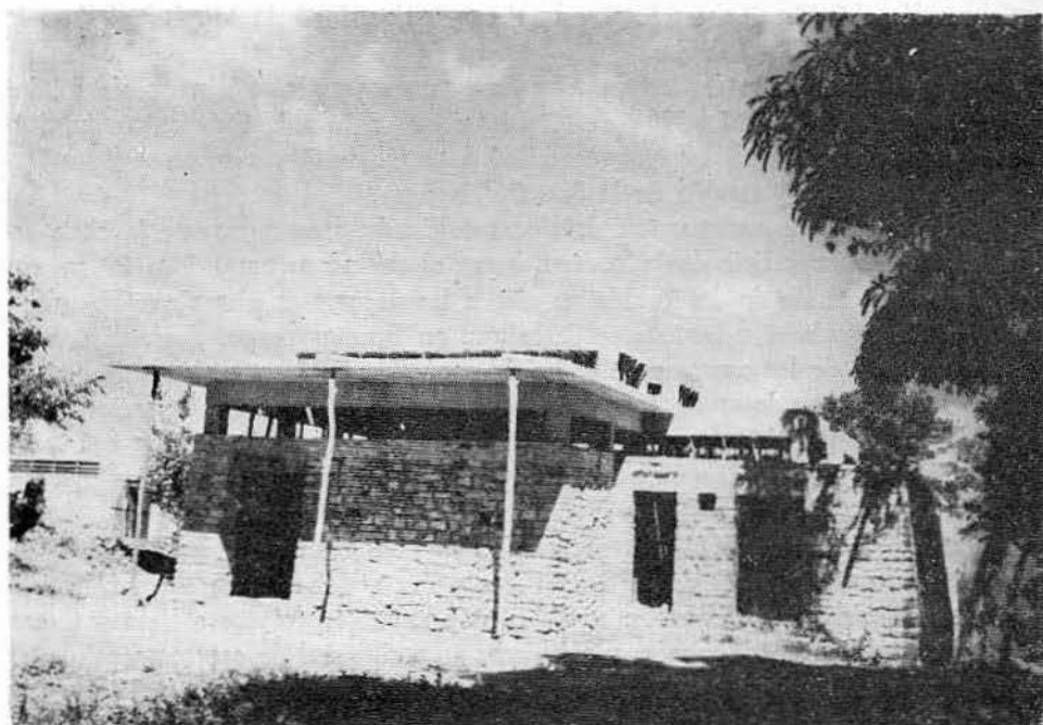
Lám. II.—Lado Oeste del Museo en vía de construcción.
