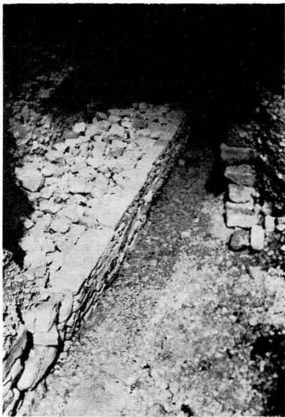
Lám. XXIX.—Acueducto: el mismo tramo, libre de escombro y con el muro Oeste parcialmente reconstruido.
