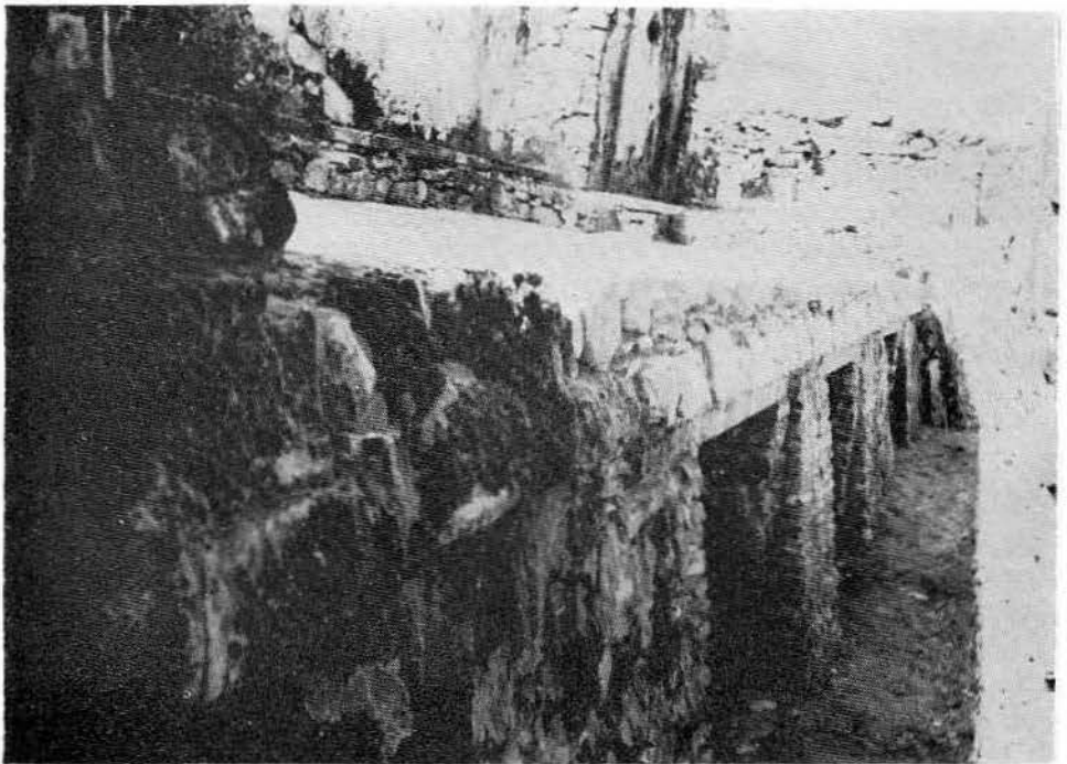
Lám. IV.—Las mismas construcciones ya restauradas.
