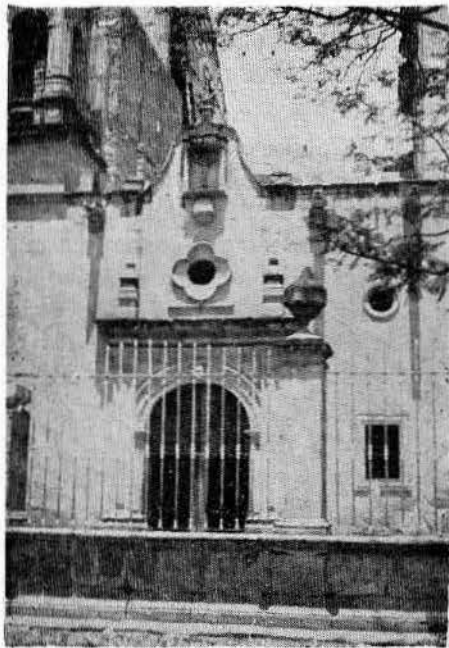
Lám. 9.—Silao, Gto. Fachada de la Capilla anexa a la Parroquia.
