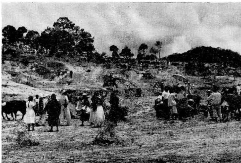
Lám. V.—Bendición de los animales que se ocuparon en los trabajos de construcción del campo aéreo.
