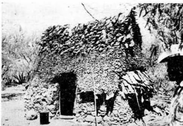
Lám. IV.—Habitación construida con piedra y material vegetal. González Ortega, Municipio de Santiago de Anaya, Hgo.
