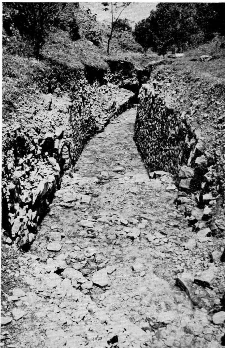
Lám. XLIII.—Acueducto; vista del tramo recientemente descubierto, que no tuvo bóveda.
