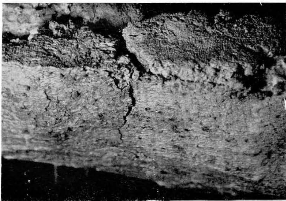
Lám. XLII.—Huellas de tejido sobre la cal que cubre la última hilera de piedras de la bóveda sobre la que descansaba la tapa.
