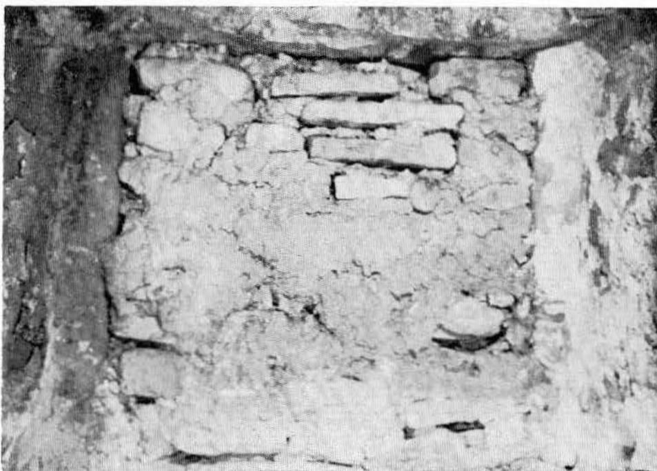
Lám. XXXVII.—Tumba del Templo XVIII-A; un muro de mampostería cierra la entrada (vista interior); en parte conserva tosca capa de cal.
