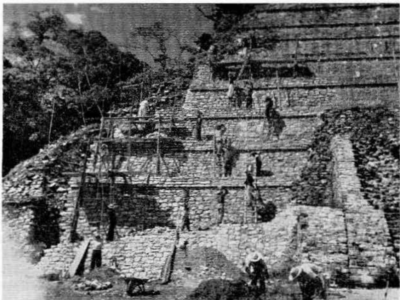
Lám. XXVIII.—La misma sección en proceso de reconstrucción.
