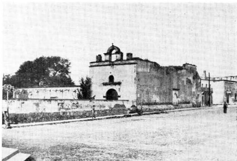
LÁM. V.—Aspecto del ex-Hospitalito de Indios de Teocaltiche, Jal., antes de los trabajos de restauración.
