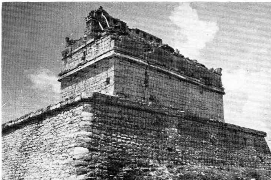
Lám. I. Lado oriente del Chichán Chob antes de su consolidación.
