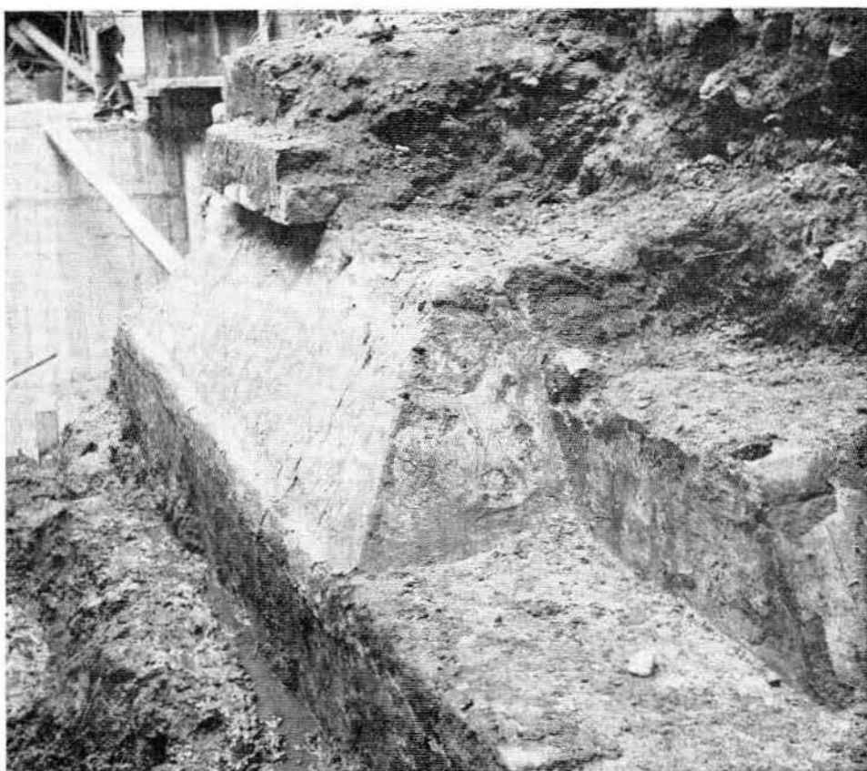
Lám. IV.—Vista del talud y moldura; en primer término, a la derecha, parte de la alfarda; nótese la humedad al pie de la plataforma.
