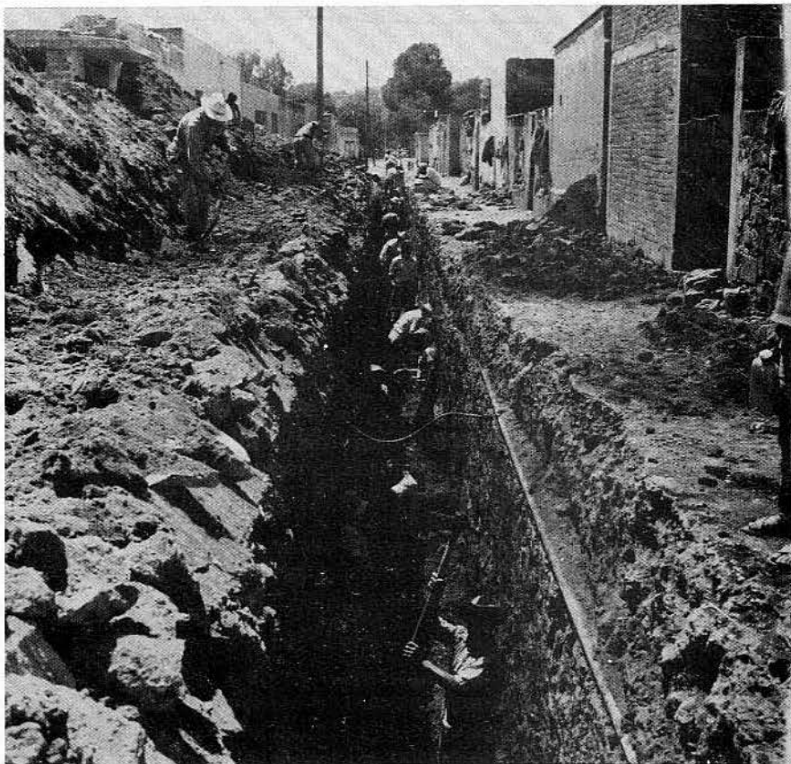
Fig 4. En total se realizaron 40 cortes estratigráficos, uno o más en cada cuadra, para ver en detalle las capas
