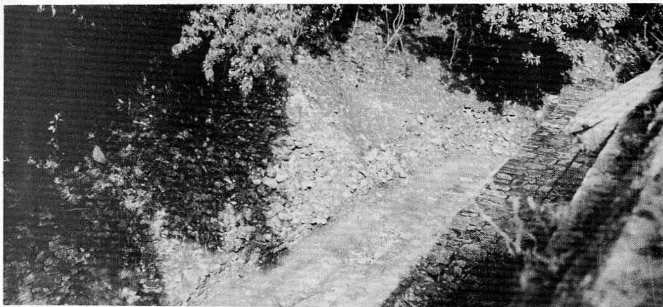
Fig 5. Los antiguos mayas construyeron un muro de contención en la parte posterior del Templo de las Inscripciones, pero, con el correr del tiempo, se fue minando la construcción, hecho que hizo necesario reconstruirlo casi del todo
