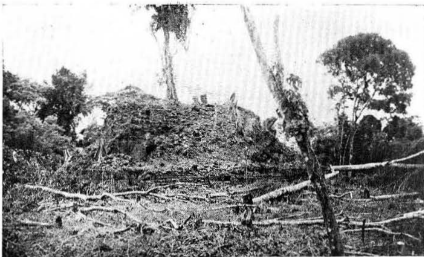
Foto 10. Edificio B después del desmonte.
