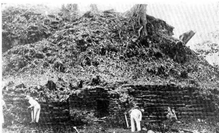
Foto 11. Frente del edificio B.
