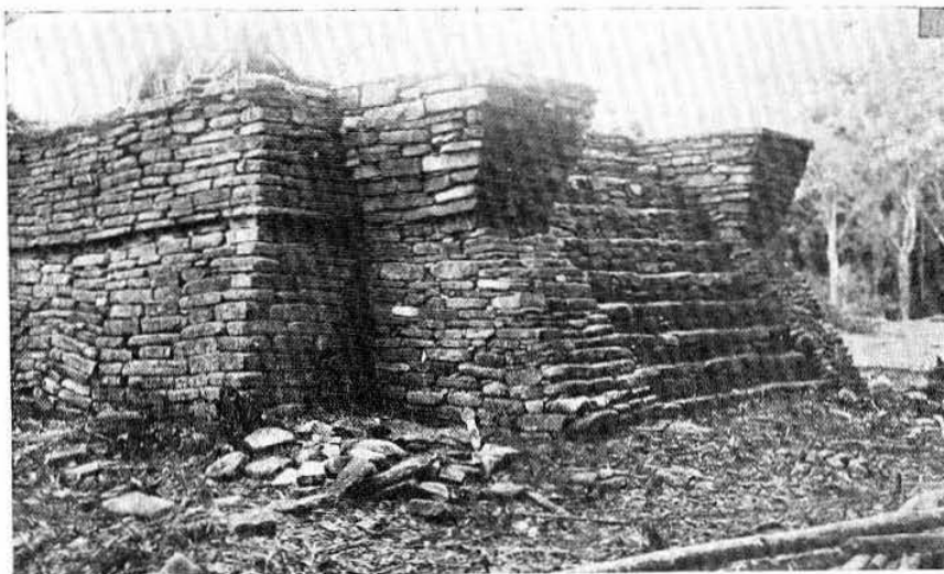
Foto 16. Escalinata poniente del edificio F.
