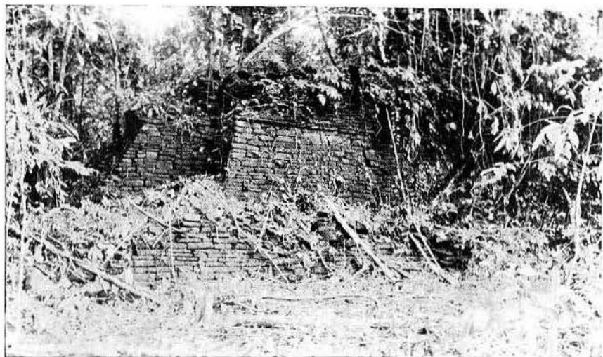
Foto 15. Condiciones en que fué encontrado el edificio F. Lado sur.
