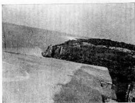
Fig. 13.—El techo después de reconstruído.
