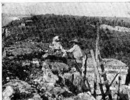
Fig. 12.—Estado en que se encontró el techo del Castillo.
