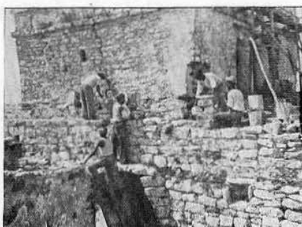
Fig. 14.—Fachada norte en secuela de reconstrucción.
