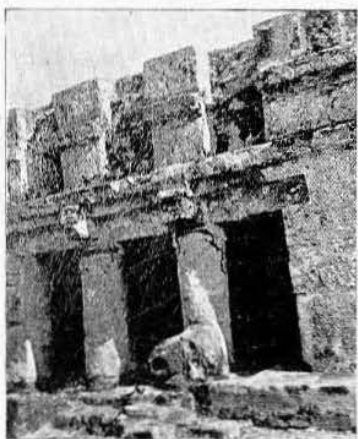
Fig. 11.—Fachada del Castillo.
