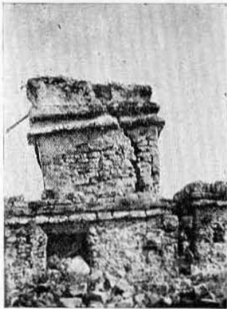
Fig. 59.—Templo número 5 (antes de los trabajos).
