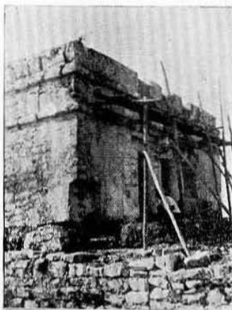
Fig. 18.—Fachada del Castillo (antes de los trabajos).
