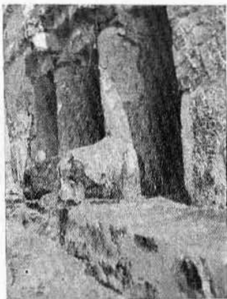
Fig. 10.—Pórtico del Castillo consolidado.
