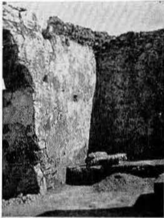
Fig. 57.—Angulo N. O. de la subestructura.
