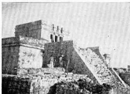
Fig. 26.—El Castillo (después de los trabajos).
