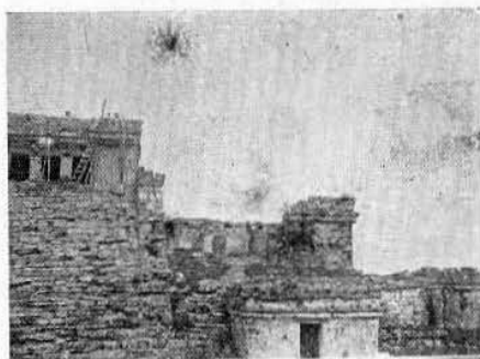
Fig. 24.—Galería sur de la subestructura (antes de los trabajos).
