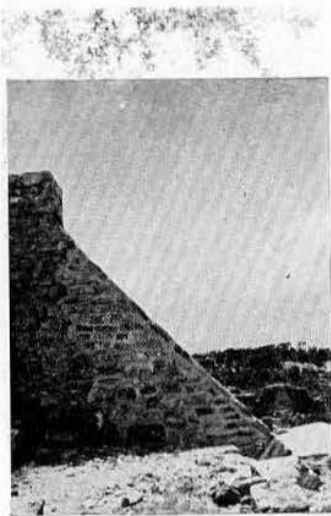
Fig. 22.—Alfarda (después de los trabajos).
