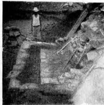
Lám. D, fig. 4.—Escalinata del Edificio A después de ser desescombrado.
