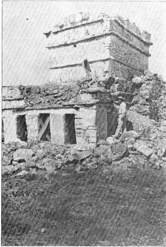
Fig. 23.—Templo No. 16. Fachada Sur y contrafuerte.
