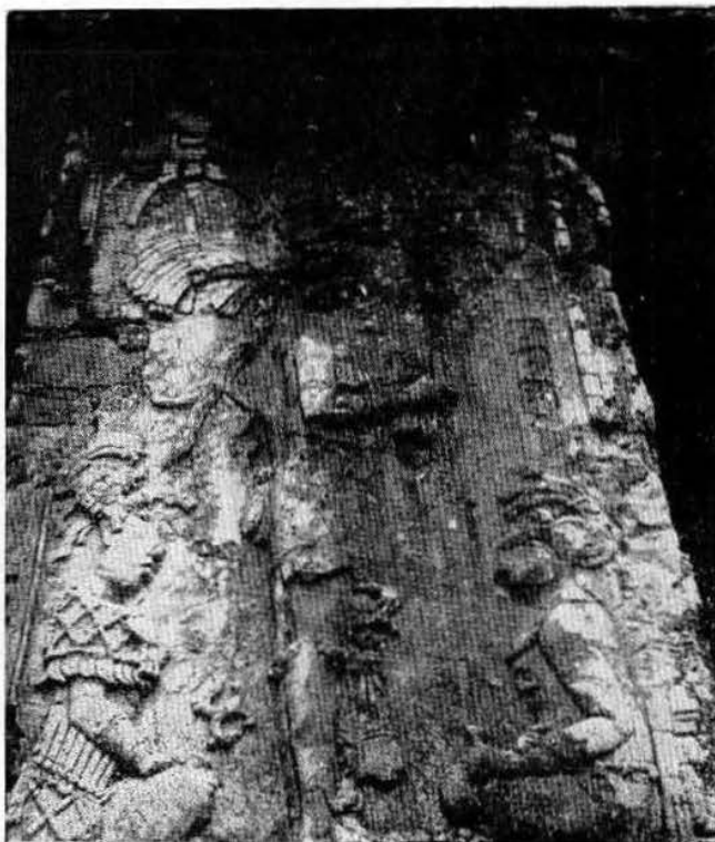
Lám. VIII.—Bajorrelieve de estuco antes de ser restaurado.
