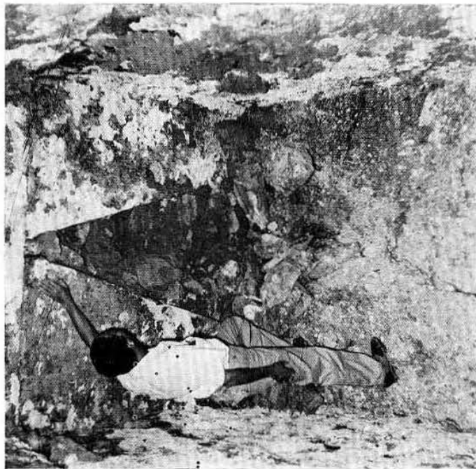
Lám. XXIV. A 16 metros por debajo del piso del Santuario de las Inscripciones aparece un nuevo tramo de bóveda, obstruido como el resto de la escalera interior, por fuerte relleno de piedras amarradas con barro.
