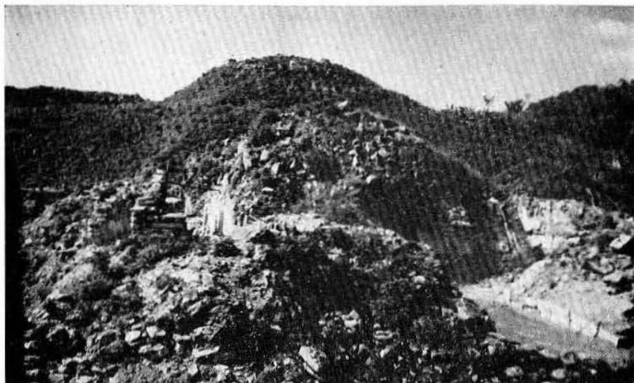
Lám. XI. Aspecto del núcleo central del Edificio A, al emprenderse la temporada de 1951.
