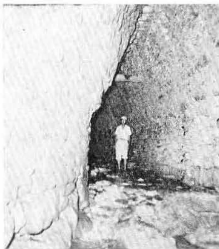
Lám. XIV. Tramo subterráneo del Acueducto.
