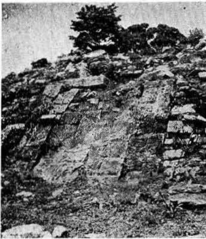
Lám. IX. Sección central del paramento interior de la plataforma del mismo Juego.
