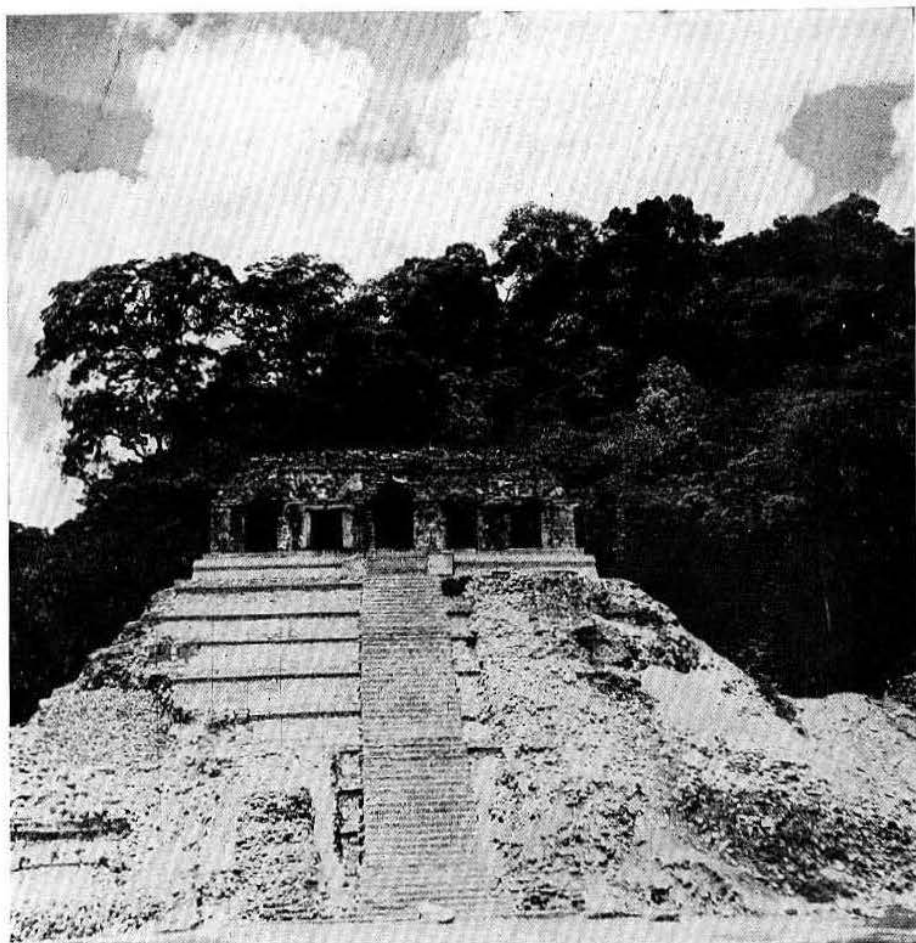
Lám. XXII. El templo de las Inscripciones al finalizar la temporada (el basamento del templo se ve reconstruido, los cuerpos superiores de la pirámide se consolidaron y la escalinata original quedó reconstruida; los cuerpos inferiores de la pirámide acentuaron su deslizamiento al retirarse el escombro en su base).
