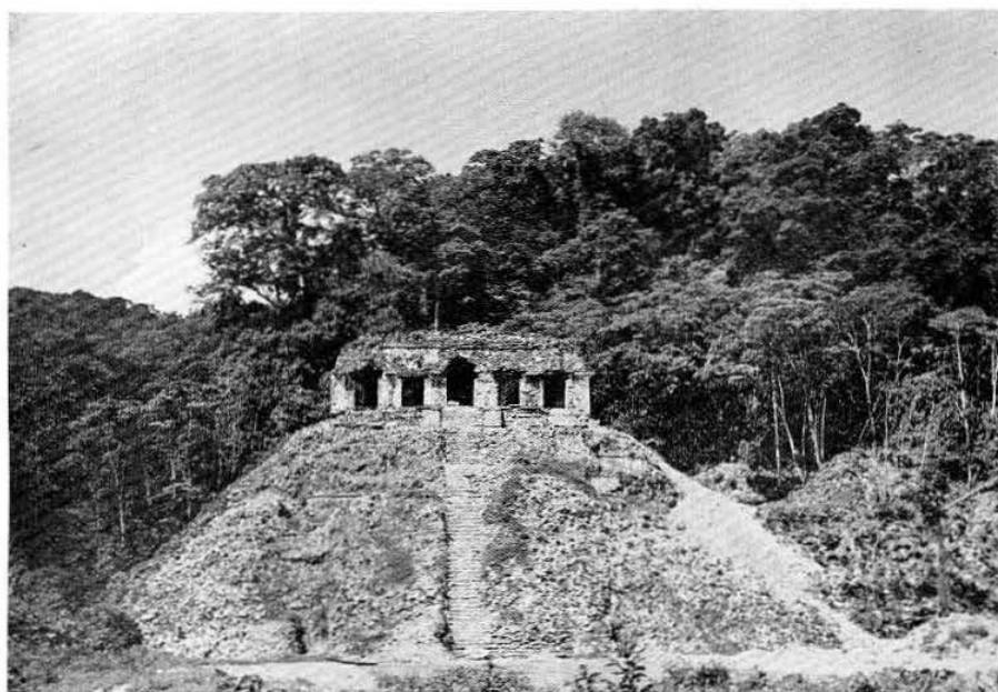
Lám. II. El Templo de las Inscripciones después de los trabajos de 1950.
