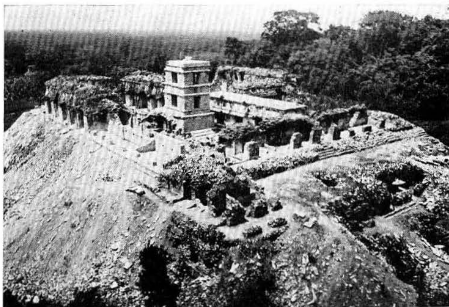
Lám. XVI. La misma vista después de las exploraciones y obras de restauración.
