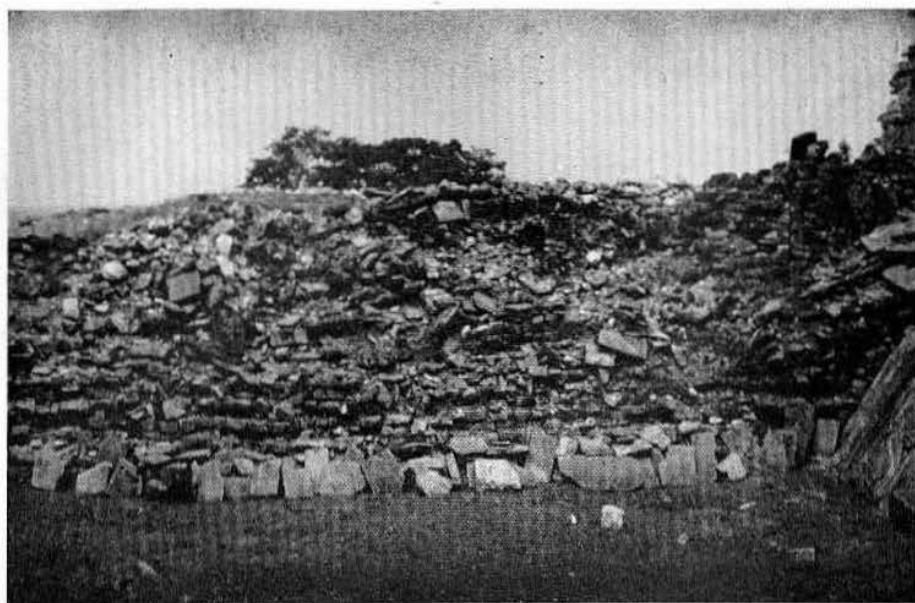
Lám. V. Patio Noreste de El Patio: escalera norte antes de las exploraciones.
