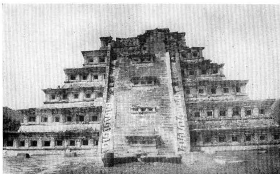
Lám. IV. La Pirámide de los Nichos al concluirse la temporada. Nótense a la derecha las diferencias en la alfarda y nichos.
