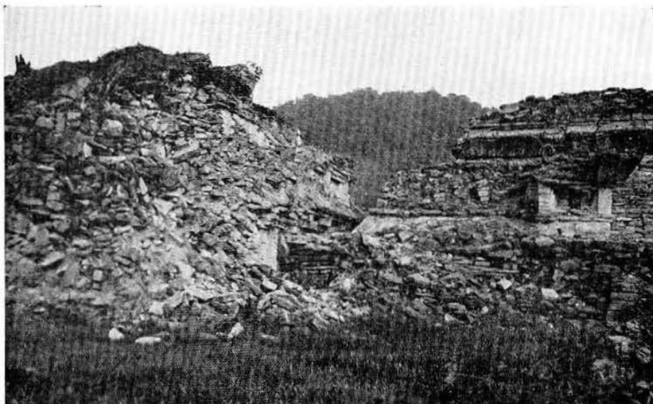
Lám. XXII. Aspecto del lado poniente del edificio C, al iniciarse los trabajos de conservación.
