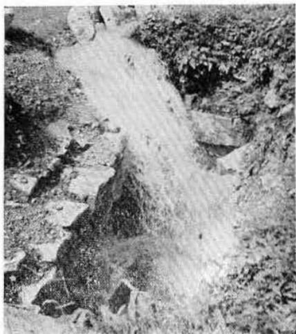
Lám. XIII. Después de la lluvia, el Otolum corre en la superficie antes de precipitarse en el Acueducto por la sección en que se derrumbó la bóveda.
