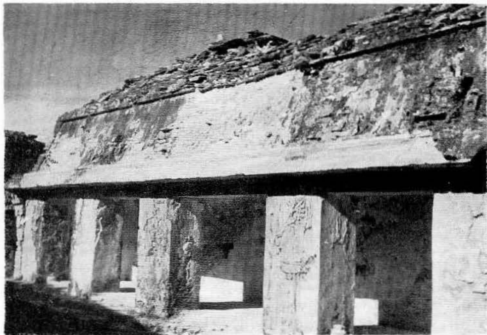
Lám. VII.—Galería Este del Patio Noroeste del Palacio después de su restauración.
