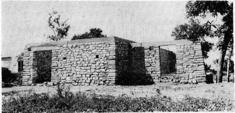
Lám. I.—Museo: Muros de la sala de exhibición y de la bodega que se construyeron durante la temporada.
