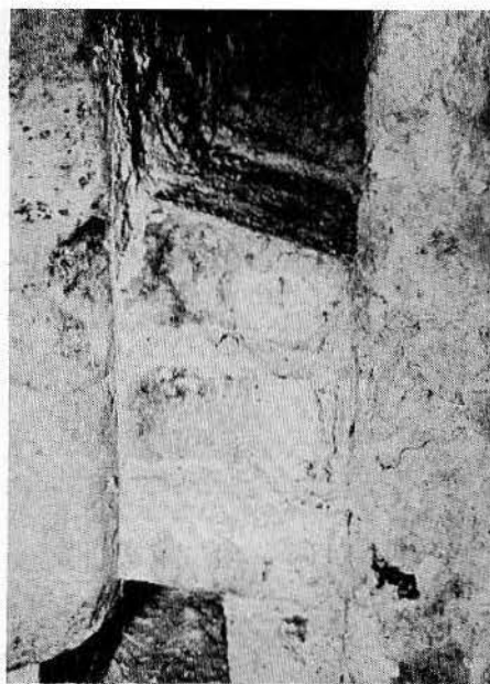
Lám. XXIX.—Contrafuerte adosado en el lado Oeste del sepulcro después de retirarse la hilada de piedra superior.
