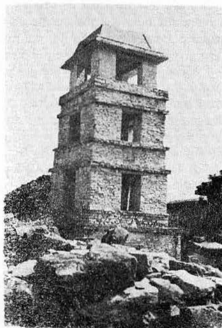
Lám. VI.—La torre con su techo casi terminado de reconstruir.
