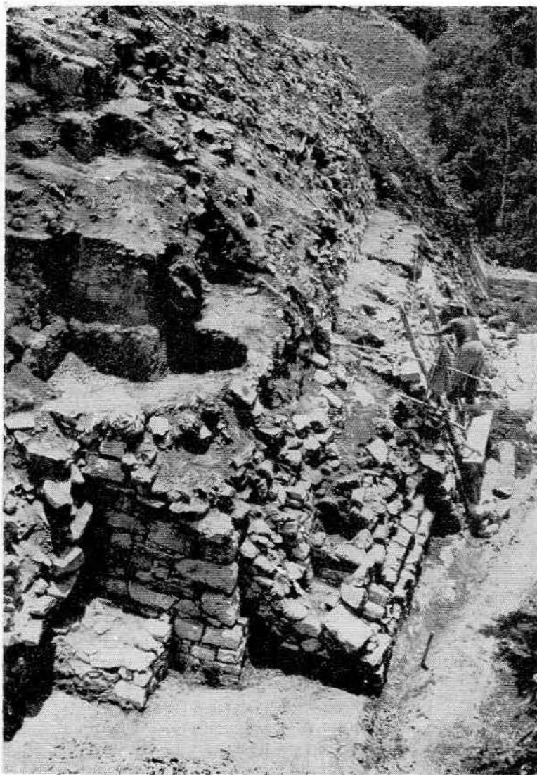
Lám. XV.—Lado Sur y esquina S. O. de la pirámide del Templo de las Inscripciones durante las exploraciones.
