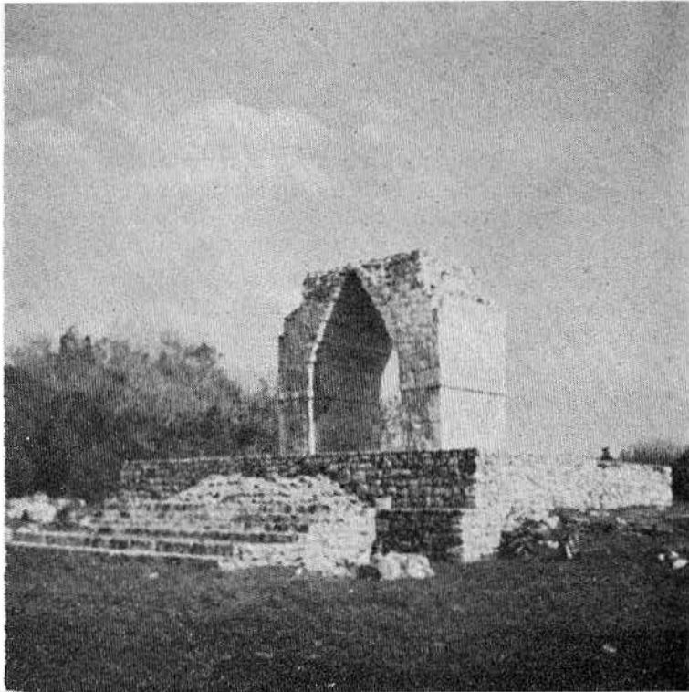
Lám. I.—El Arco de Kabah, Yuc., al concluirse en 1956 su restauración, incluyendo la de la plataforma en que se apoya.
