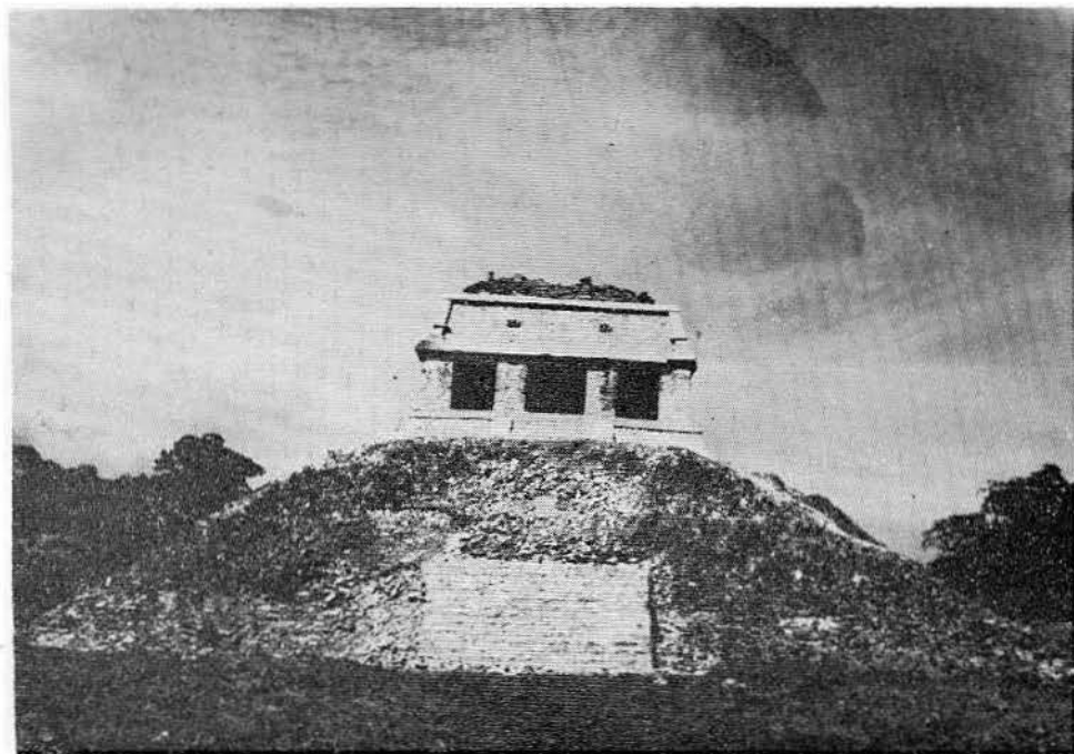
Lám. XVII.—Templo del Conde en vía de reconstrucción, con parte de la escalinata.
