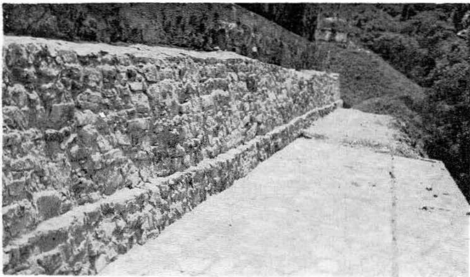
Lám. XX.—Templo de las Inscripciones: lado Sur del basamento después de ser consolidado, y plataforma en parte revestida de lajas.
