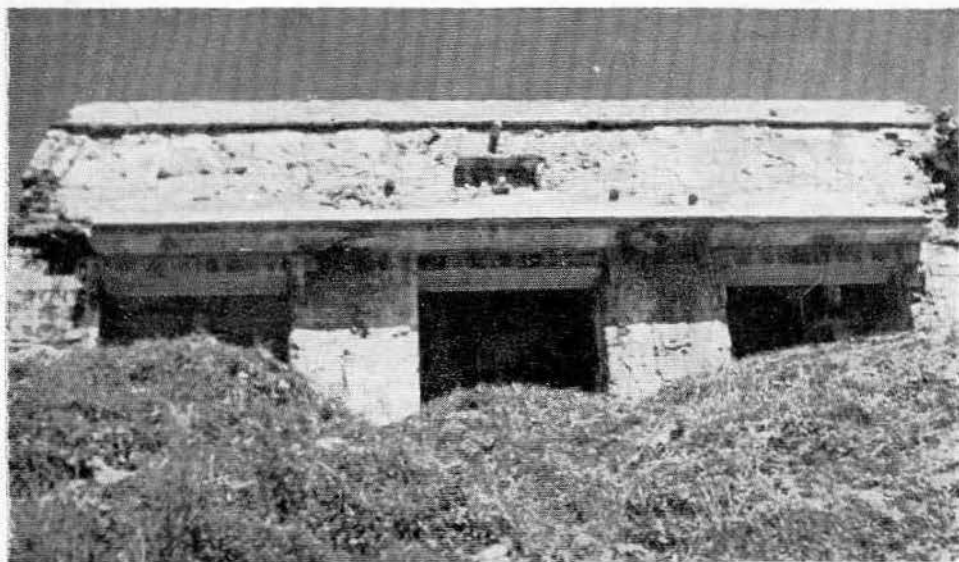
Lám. V.—Galería exterior Este del Palacio después de su restauración.
