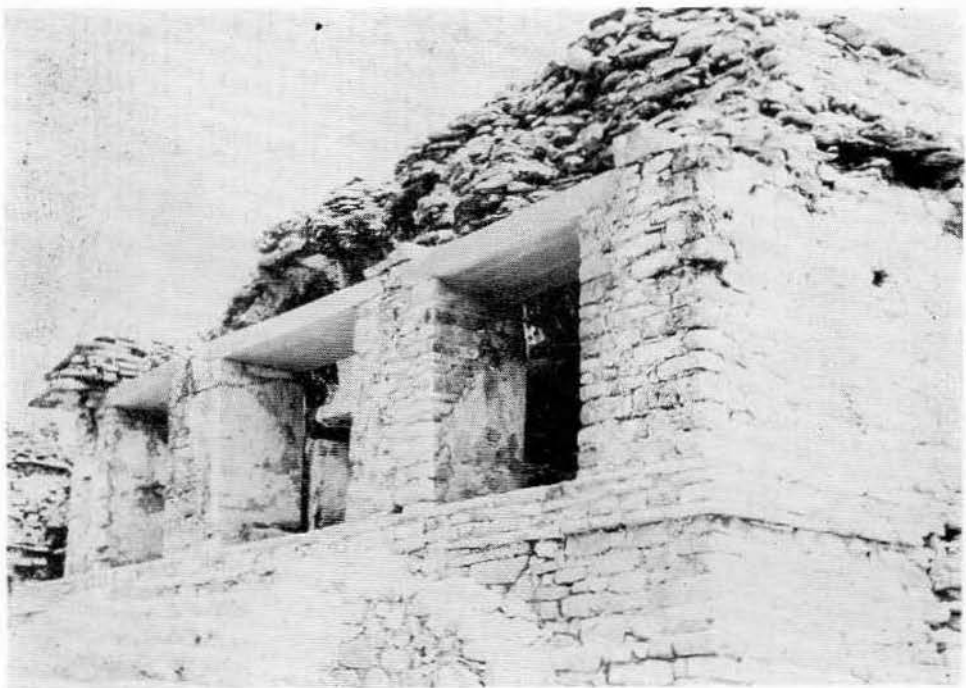
Lám. XII.—El mismo templo explorado con su basamento restaurado, la escalera consolidada, y dinteles de concreto en el pórtico.
