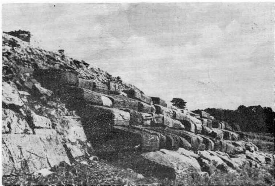
Lám. XIX.—Escalinata del Templo X después de acomodar las piedras movidas.
