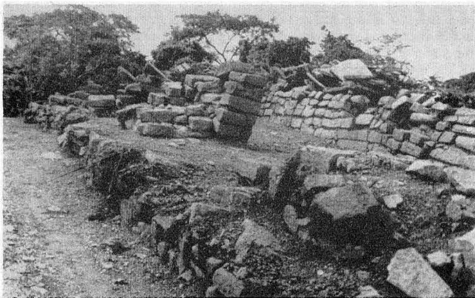
Lám. VIII.—Templo X, del que sólo quedan las filas inferiores de piedras en el muro posterior y en los pilares, todo sumamente desplomado hacia Norte.
