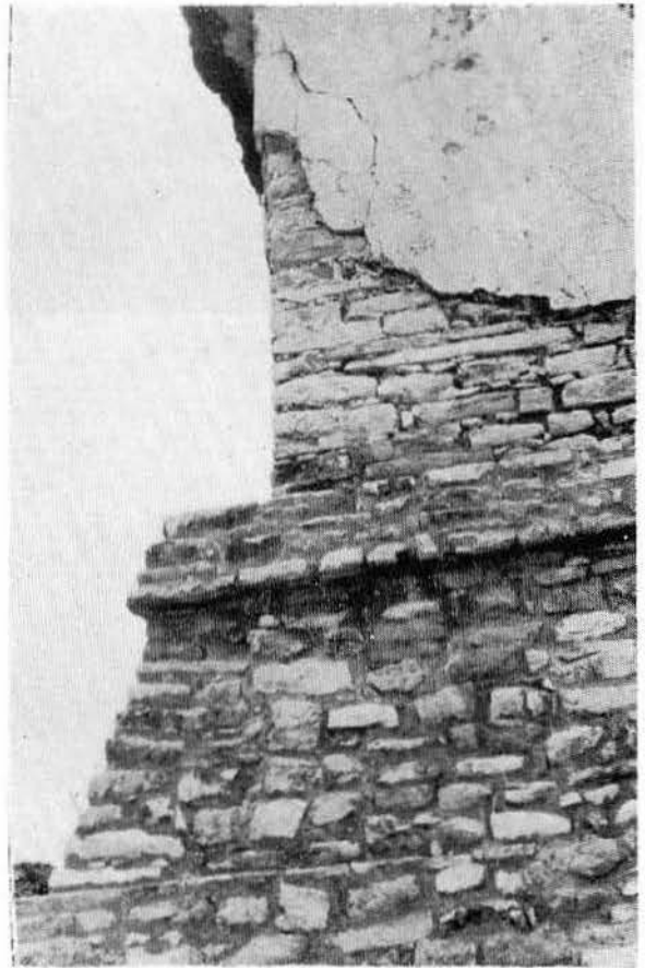
Lám. XXVIII.—La misma esquina reconstruida.
