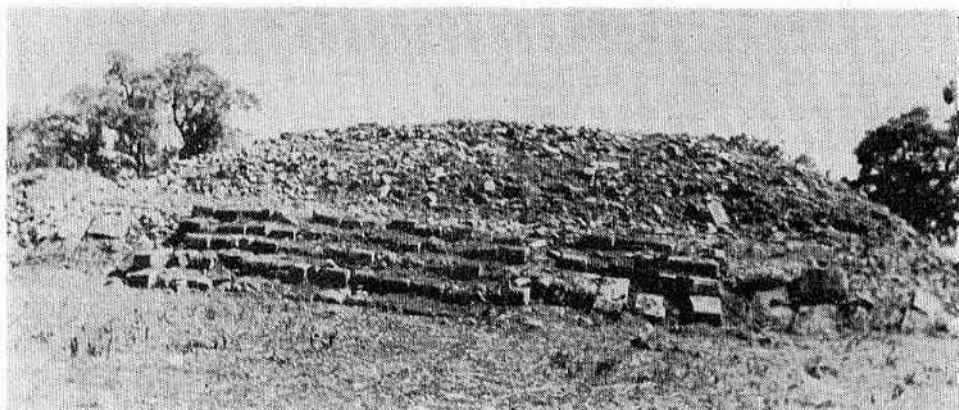
Lám. VII.—Templo X al iniciarse su exploración: Son visibles los grandes bloques tallados de su escalinata.
