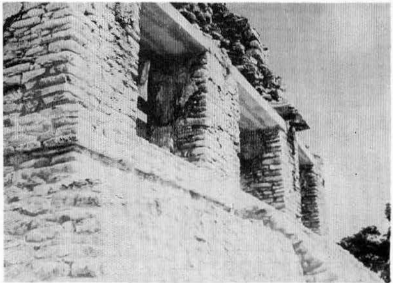
Lám. XXIV.—El mismo templo con su basamento reconstruido.
