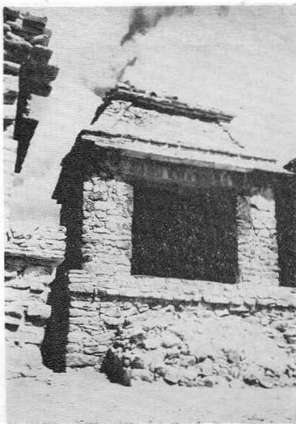
Lám. IX.—Grupo Norte: la fachada del Templo III reconstruida.
