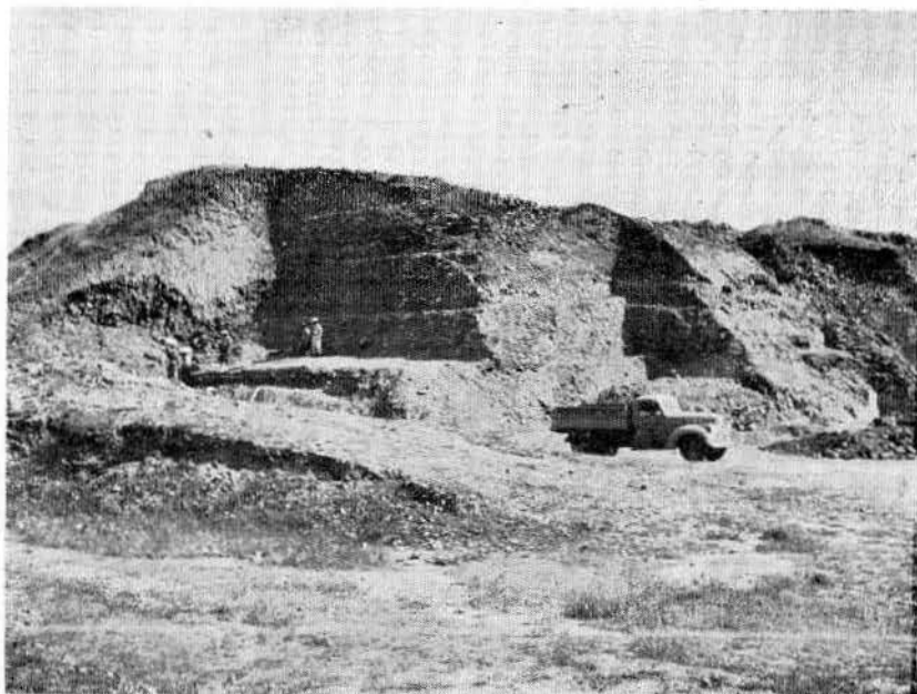
Lám. 48.—Edificio C. Vista general de los trabajos efectuados durante la VIII Temporada.
