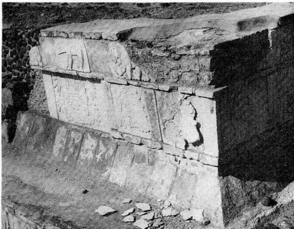
Lám. 16.—Edificio B. Defectuosa técnica utilizada en la restauración del ángulo noreste del segundo cuerpo de la pirámide.
