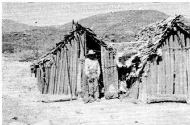
Lám. III.—Habitación construida con material vegetal. Orizabita, El Capulín, Municipio de Itzmiquilpan, Hgo.
