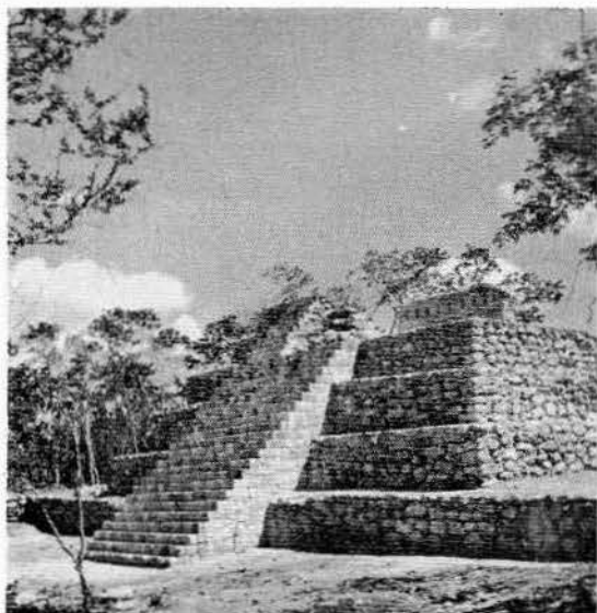
Lám. IX.—La misma estructura C reconstruida. Al fondo la crestería de la estructura A. Lado oeste, esquina suroeste.
