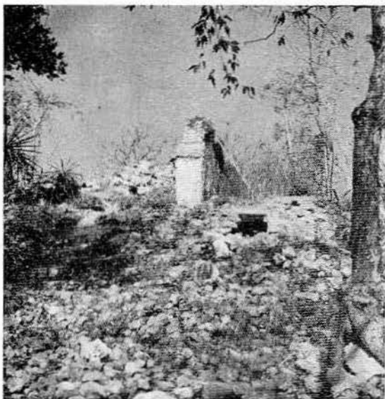
Lám. VI.—Estructura A con la crestería visible, antes de los trabajos; lado sur.
