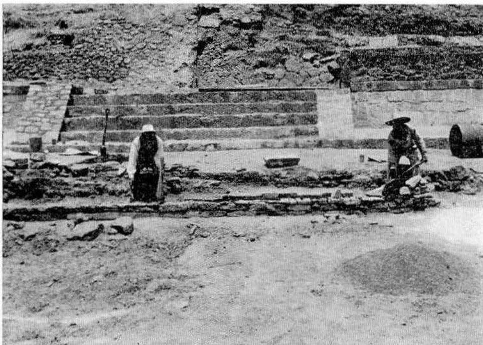
Lám. VII.—Reconstruyendo la escalinata de la estructura III; atrás, la escalera de la estructura IV.
