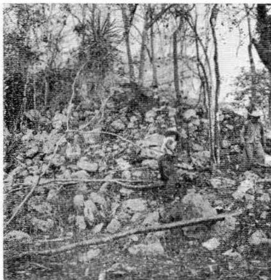
Lám. VIII.—Estructura C de Mul-Chic antes de los trabajos; lado oeste, esquina suroeste.
