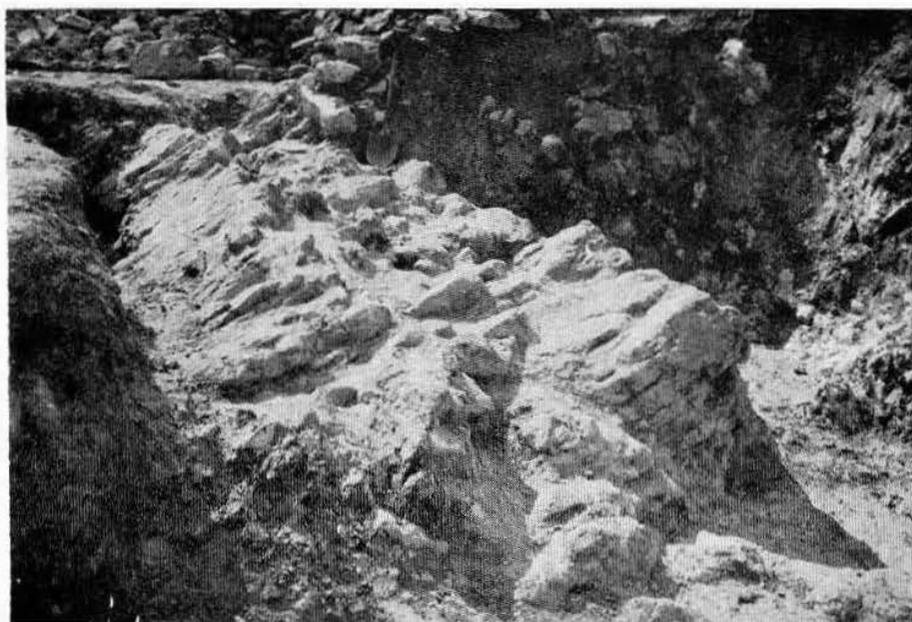
Lám. XVIII.—Excavación en la esquina noreste de la pirámide, mostrando la roca natural y la sección en que se retiró una capa de tepetate blando para hacer la cimentación de concreto.
