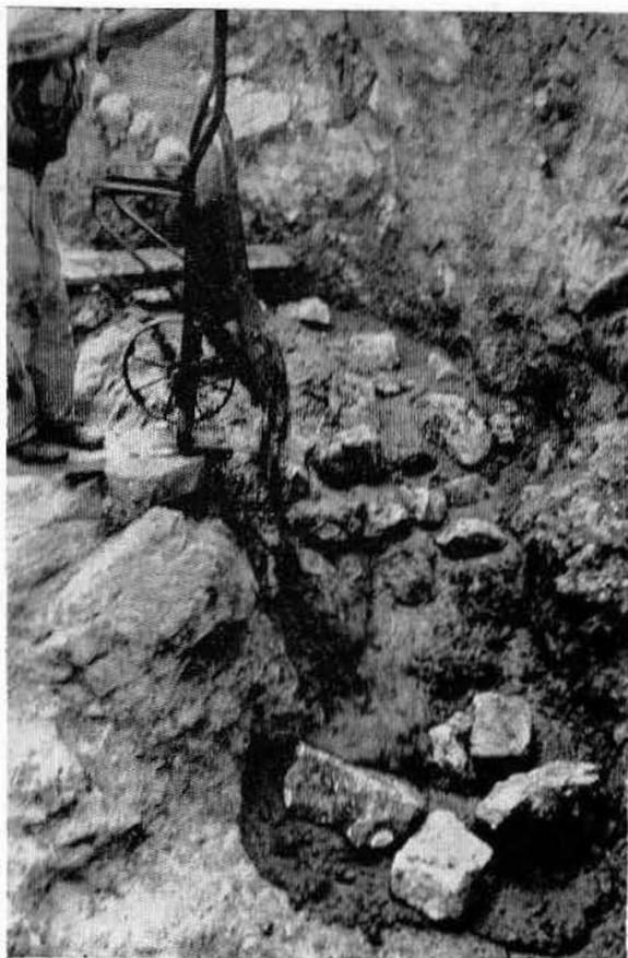
Lám. XIX.—Echando concreto en la excavación mencionada anteriormente, para servir de base firme en la esquina de la pirámide.
