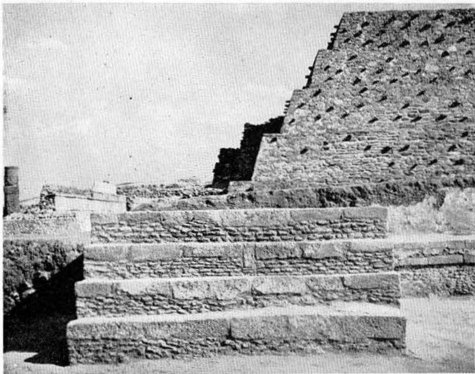
Lám. XII.—Edificio 3, fachada norte. Los cuatro escalones ya restaurados.
