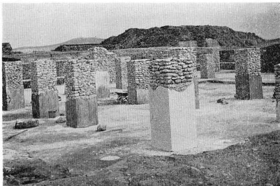
Lám. XVII.—Edificio 3, Sala 2. Colocando el aplanado de estuco sobre los pilares ya levantados con pequeñas piedras.
