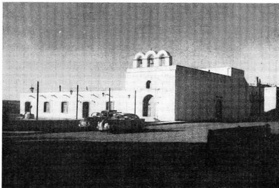
LÁM. VI.—El mismo monumento, después de efectuadas las obras de restauración correspondientes a 1969.
