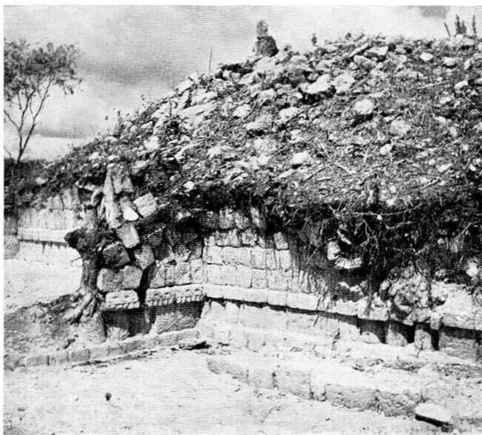
Lám. III.—Estructura II. Entrada al cuarto 3, situado al oeste de los cuartos 1 y 2.
