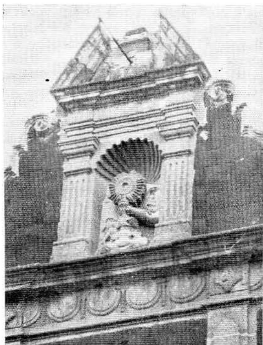
Lám. II.—Detalle de la hornacina, de la casa de la lámina anterior.
